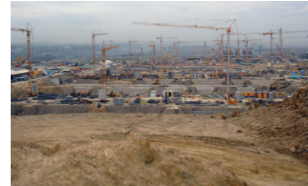
Budowa obiektów targowych w okolicach Stuttgartu
